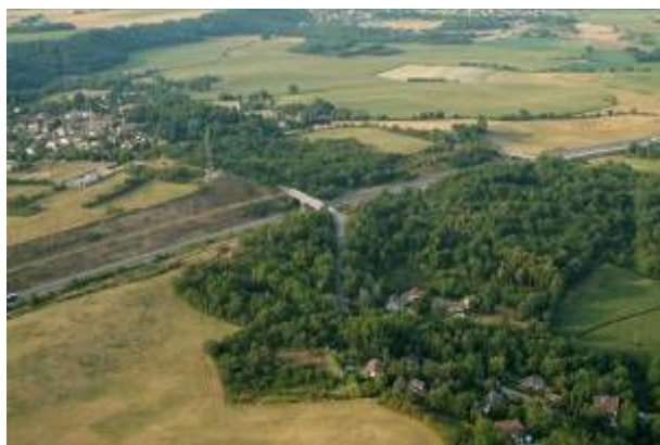
➤ Franchissement de la butte de Béligneux par l'A42
